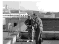
アンテナ設営は安全第一
