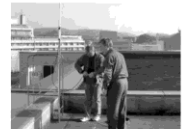
アンテナ設置は安全第一
