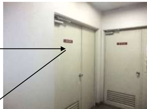
地下備蓄倉庫
