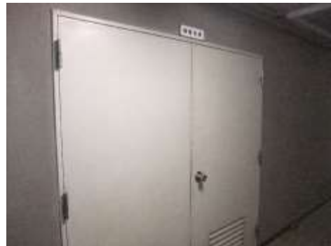
地下備蓄倉庫
