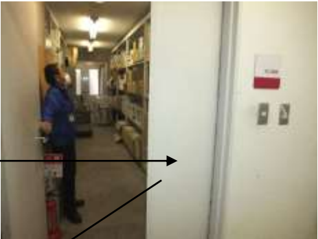
地下防災倉庫
