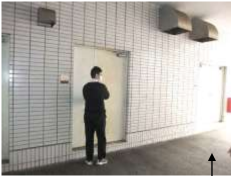
本館奥側の倉庫(1F)
